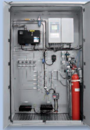
Analysenmeßanlage zur kontinuierlichen Messung von Verunreinigungen in der Wassererzeugung. Die Anlage ist für fünf Probenströme und automatische Kalibrierung des Analysensystem in einem isolierten Schuttschrank aufgebaut.
