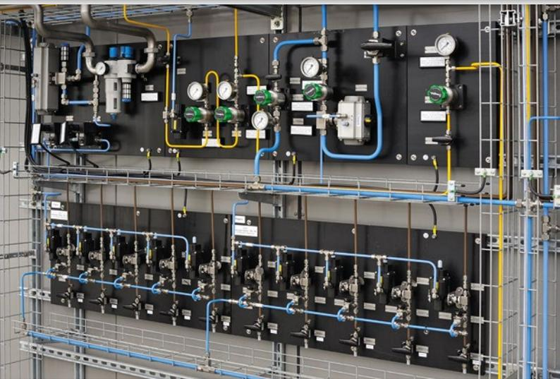
Gasaufbereitung für den Analyseraum / Gas treatment for the analysis area
