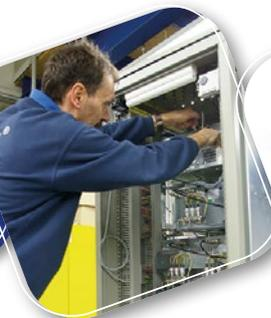
Verrohren von Analysenschränken / Piping of analysis of cabinets
